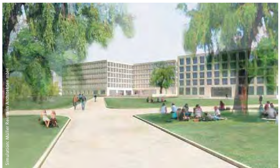
Ausbaustufe II: Im August 2009 wird der erste Spatenstich für den Fakultätsbau der Geowissenschaften (in der Mitte) und die neue Zentralverwaltung der Universität (rechts) am Campus Westend gesetzt. Der Siegerentwurf des Berliner Architektenbüros Müller Reimann orientiert sich an der Ästhetik des Poelzig-Baus.
