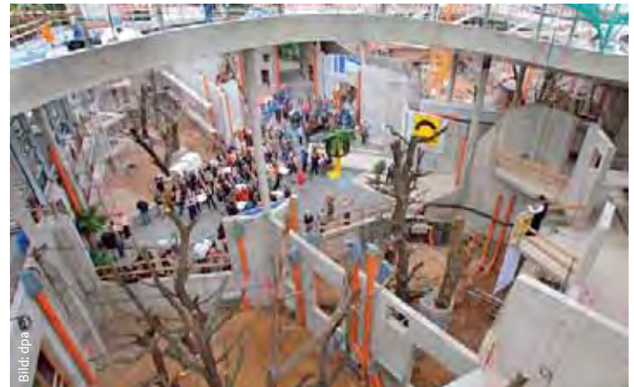
Richtfest: Ab dem Winter 2007/2008 bietet das Häus Schauanlagen für Orang-Utans, Gorillas und Bonobos sowie eine Regenwaldvoliere. Die Gesamtinvestition beläuft sich auf rund 14,5 Millionen Euro.
